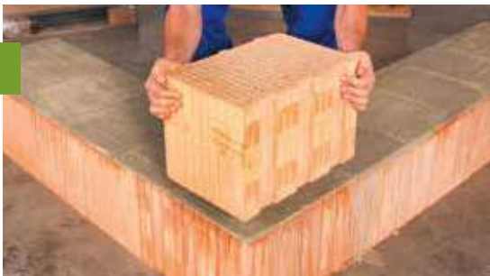
Posizionare il mattone su tutta la superficie
