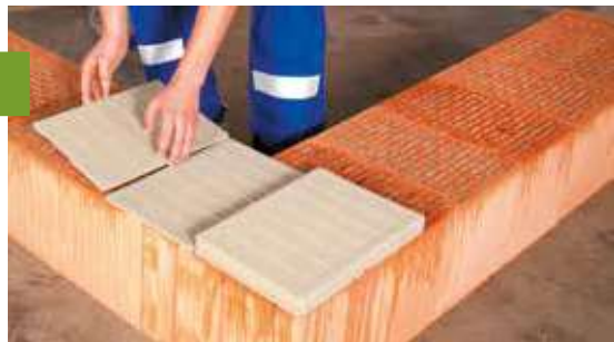
Posare sui maxit mörtelpads
